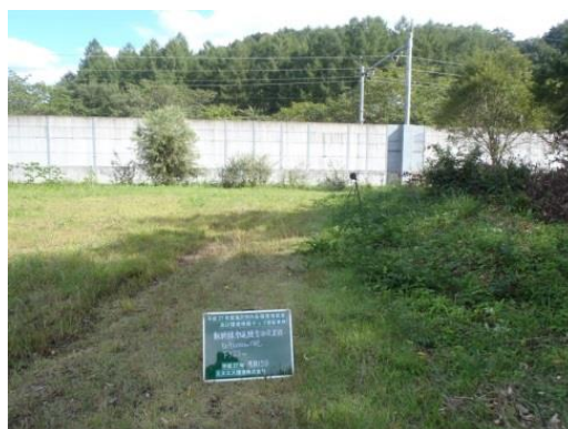
新幹線鉄道騒音測定調査地点（平成27年度調査）
