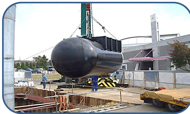
《 滝沢ふるさと交流館の緊急貯水槽建設工事：平成 19 年撮影 》
