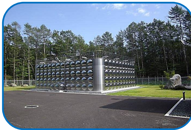
《 一本木浄水場の配水池 》
