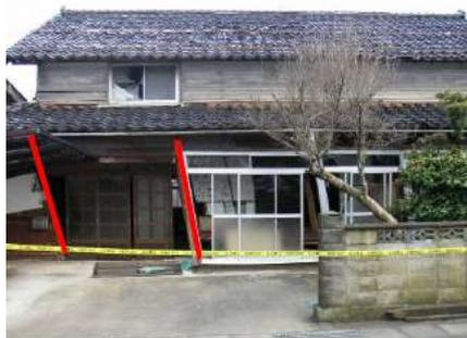
図 26：一階部分が傾斜し倒壊等のおそれがある状態
