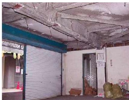
図 27：吹付け石綿等が飛散し暴露する可能性が高く衛生上有害となる状態
