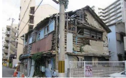
図28:外壁が外見上大きく傷み、窓ガラスが割れたまま放置され景観を損なっている状態
