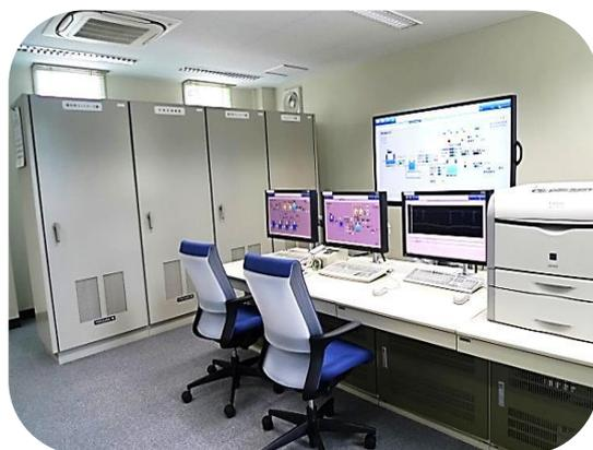
市内各所にある水道施設を集中的に監視する滝沢浄水場の集中監視装置
