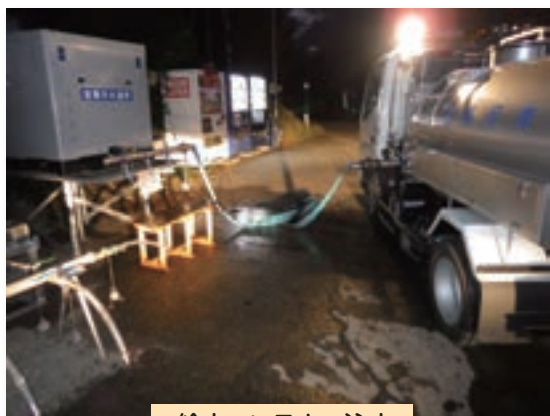
給水コンテナへ注水
