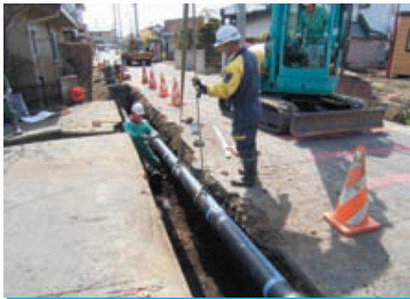
水道管の耐震化を進めています
