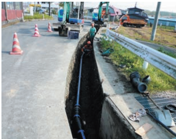
災害時の重要拠点(病院)までの耐震管整備(吉水地区)
