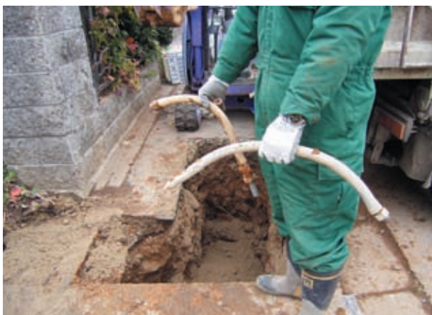
鉛製給水管の更新が進められる滝沢ニュータウン
