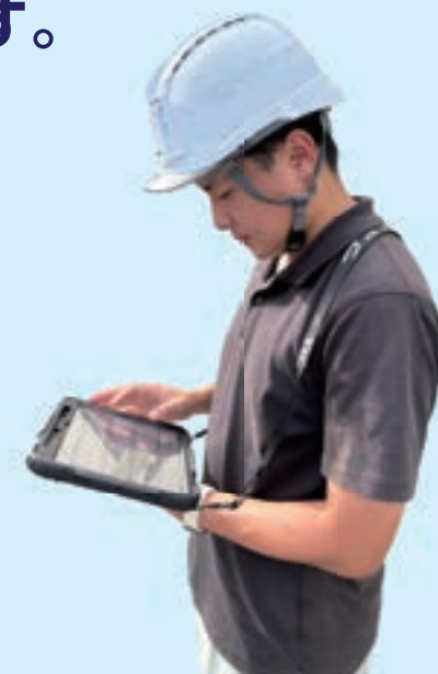
水道管更新工事の現場確認の様子
