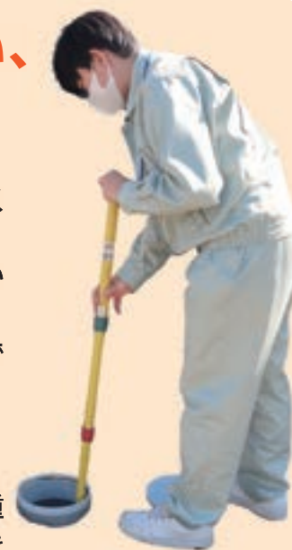
排水設備検査の様子
