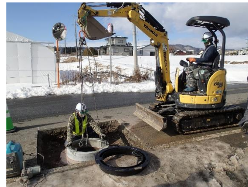
管渠・マンホール蓋の交換による 不明水対策
