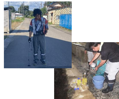
漏水調査や水質検査など
