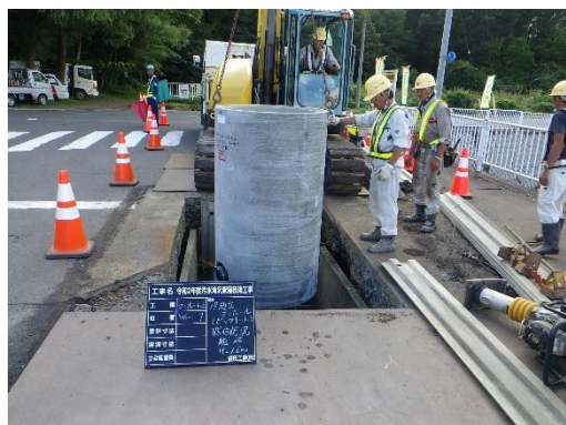
老朽管の更新や延命化
