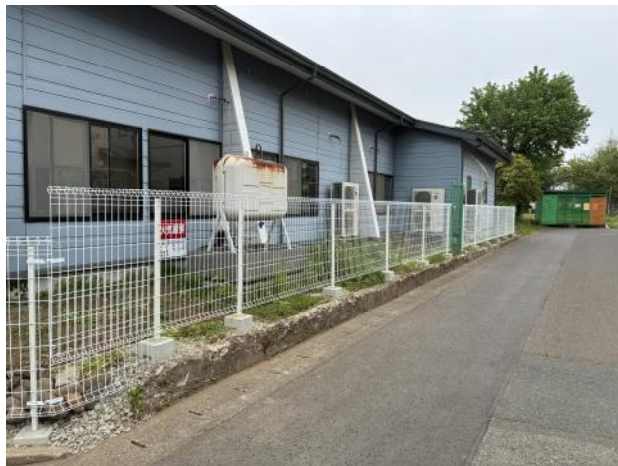
ニューシビックセンター周りの新しいフェンス
