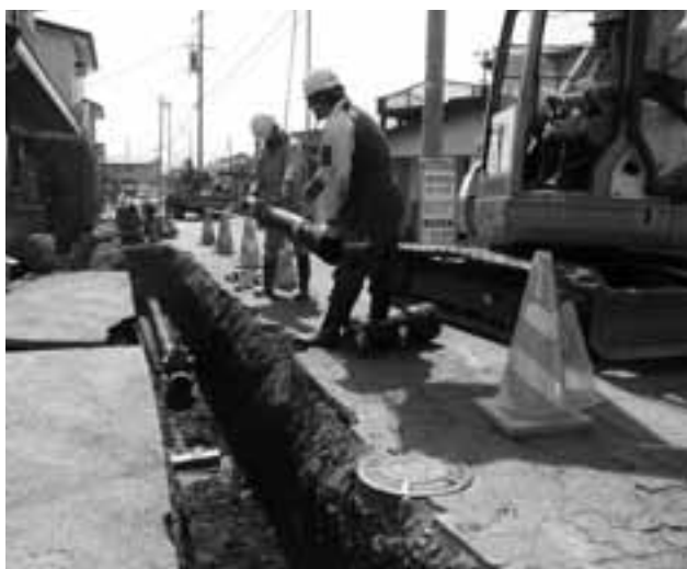
▲老朽配水管（塩化ビニール管）の更新がはじまっています
