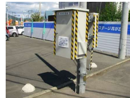
流域下水道投入点の流量計の点検・維持管理
