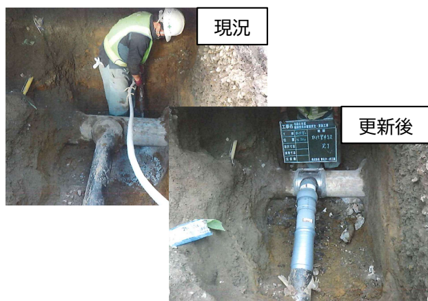
取付管改築・更新(鵜飼地区)
