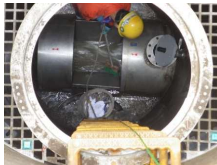
流域下水道投入点の流量計の点検・維持管理
