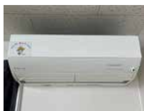
▲整備したエアコン
