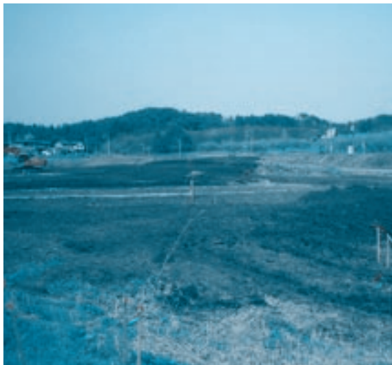
工事が進む(仮)巣子新駅
