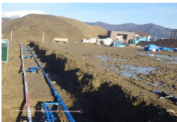
地中熱設備工事の様子
