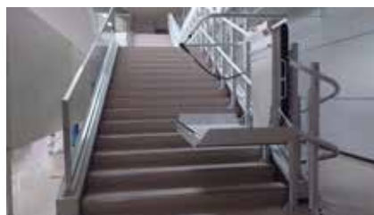
▲階段段差解消機の設置
