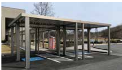
▲多目的駐車場の屋根・通路シェルターの設置
