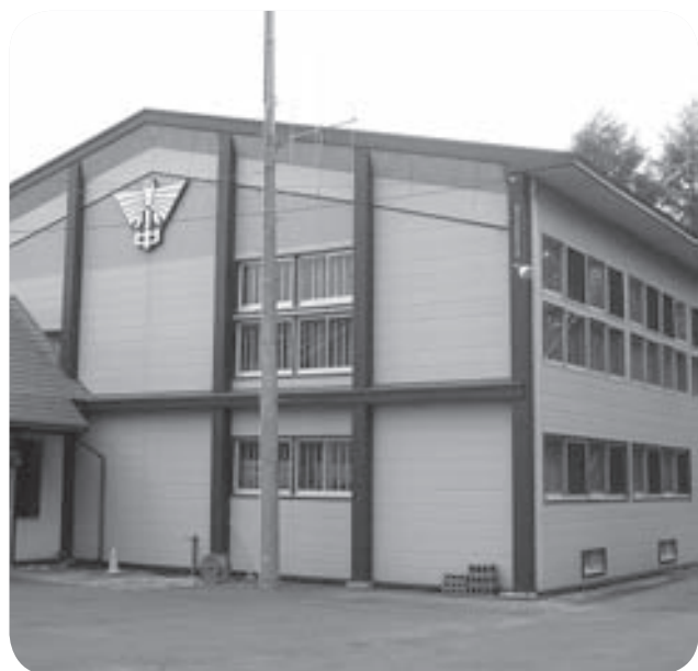
▲姥屋敷小中学校屋内運動場
