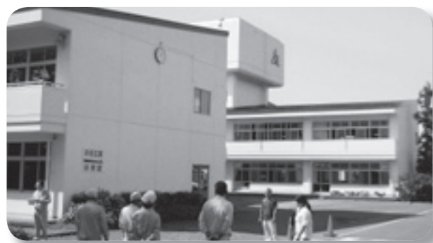
滝沢第二小学校外壁等改修事業 (3,220万円)
