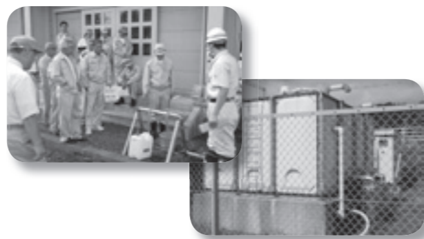
緊急貯水槽整備事業 (村内小中学校の受水槽4箇所改造工事 528万円)
