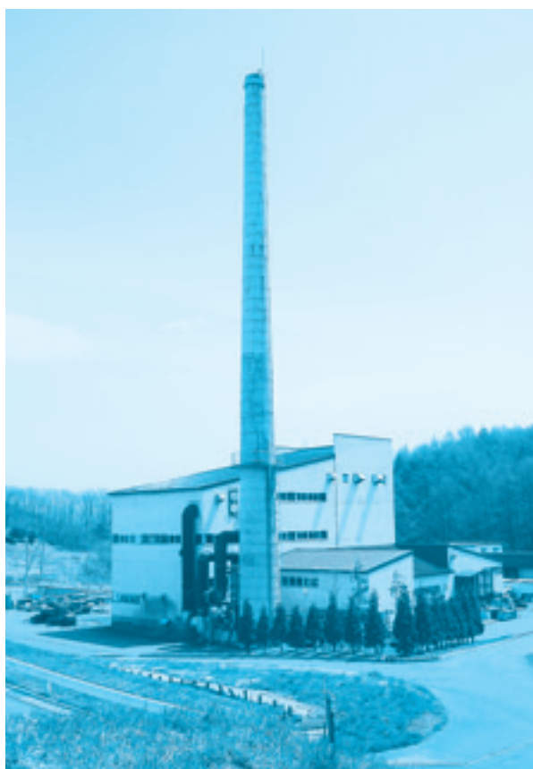
▲取壊しが必要な旧清掃センターの煙突
