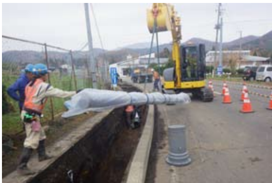
老朽管更新の様子
