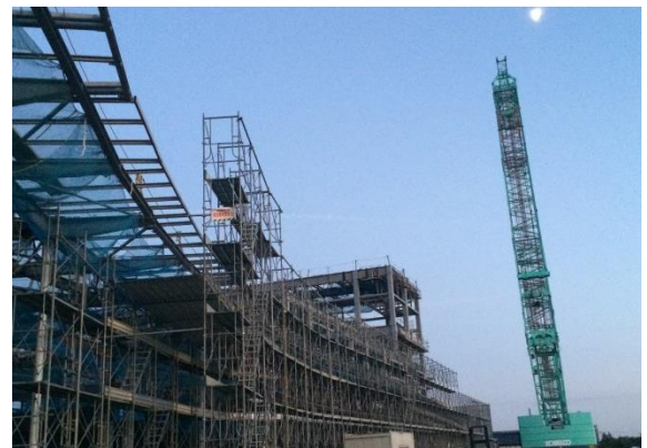
大屋根を支える鉄骨の施工の様子
