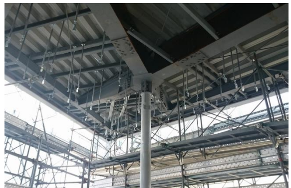
大屋根を支える独立柱とはね出し庇の施工の様子
