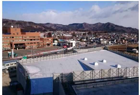
現在の大屋根の状況
