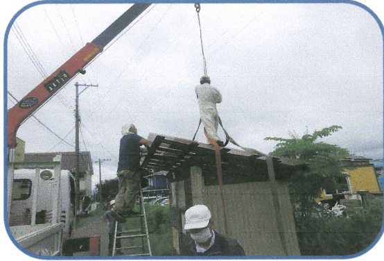
吊り上げ作業中
